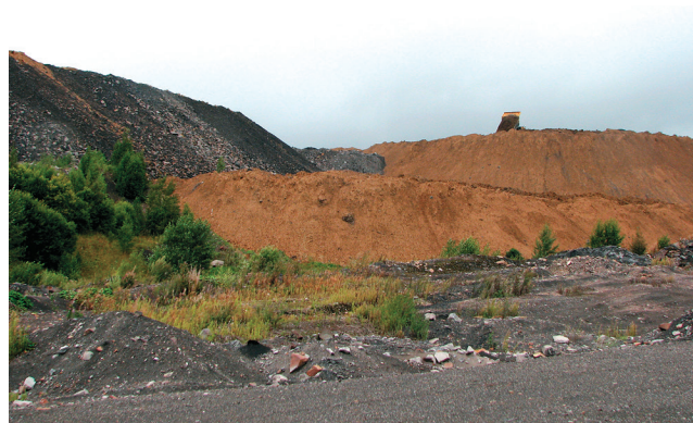
Рекультивация отвалов угольных пород при сплошной схеме нанесения ППП.
