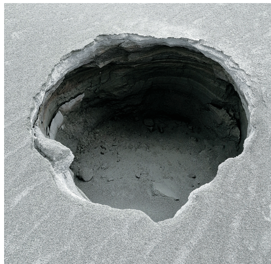
Провал на пляже на левом берегу хвостохранилища
