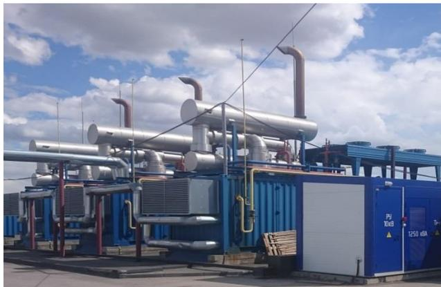
Система накопления электроэнергии мощностью 1200кВт
