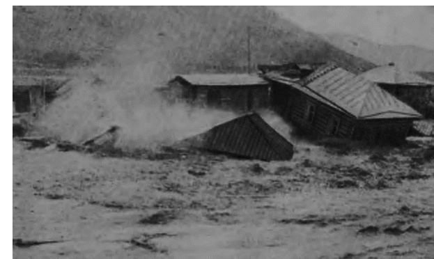
Обрушение в водогрязекаменный поток домов в г. Слюдянка, 1960 г. (фото И. Иванова)
