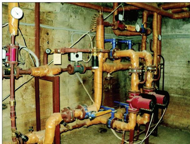
**Рис. 12.** Автоматизированный тепловой узел с приборами учета тепловой энергии и горячей воды (жилой дом Новосибирского Академгородка)
