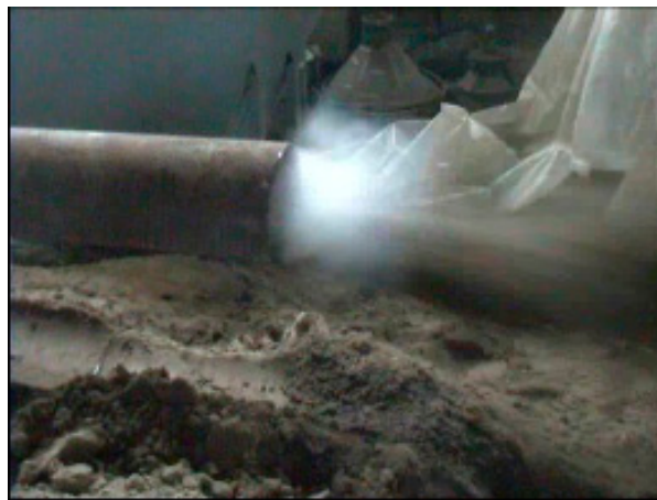
Рис. 31. Процесс порционного выхода грунта из транспортного канала.
