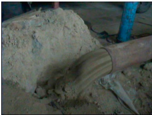
Рис. 31. Процесс порционного выхода грунта из транспортного канала.
