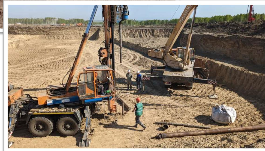
Строительная площадка «СКИФ», май 2022 года
