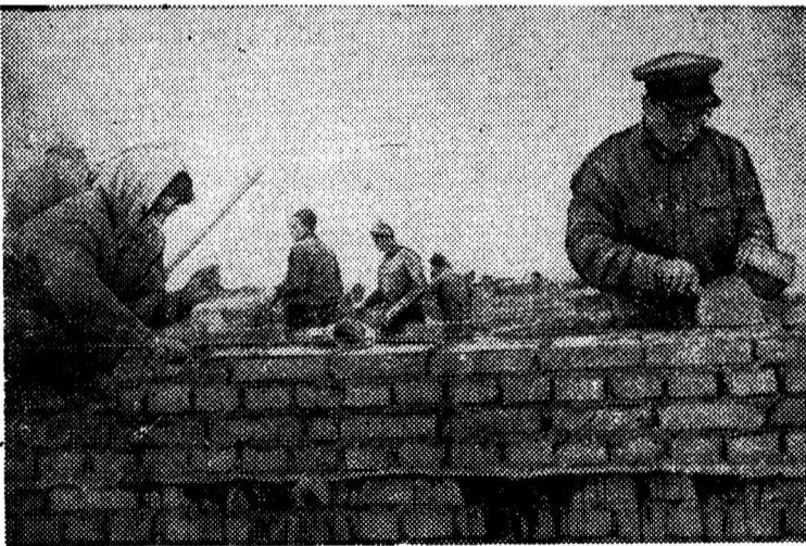
«И штукатуры мы, и плотники...»
