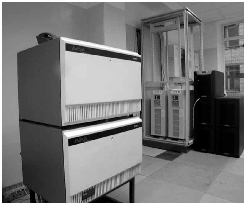
Рис. 15: Коммутационный узел КТС СО РАН на базе УАТС Definity
