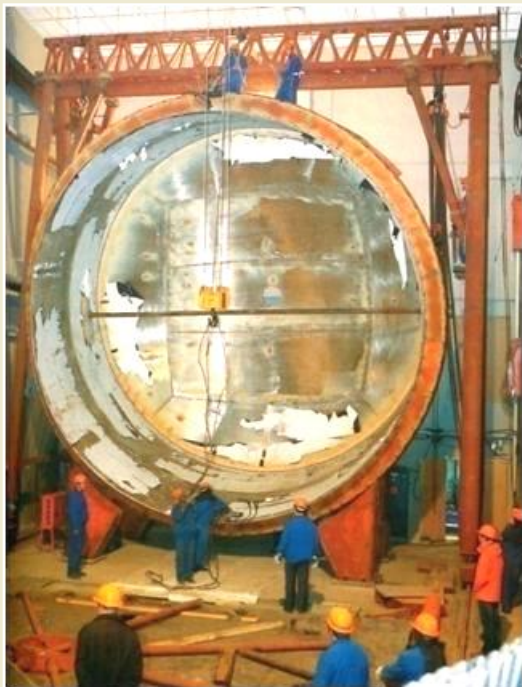
Монтаж камеры ГВУ-600
