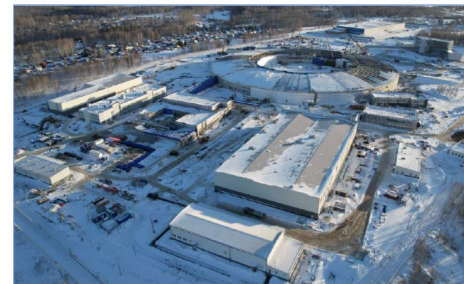
Строительная площадка «СКИФ», 22.01.2025 года
