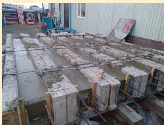
Рис. 3. Изготовление сборной части свай в построчных условиях
