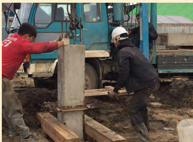
Рис. 4. Установка сборной части сваи при помощи крана-манипулятора
