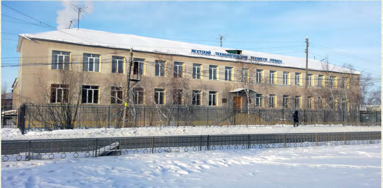
Якутский технологический техникум сервиса им. Ю. А. Готовцева, г. Якутск. Здание построено в 1977 г.
