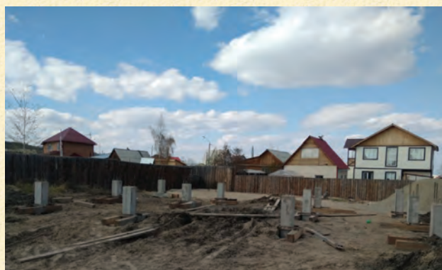
Рис. 2. Фундамент из сборно-моноклитных свай
