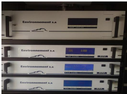
Автоматические газоанализаторы французской фирмы «Environnement» уже работают на БПТ
