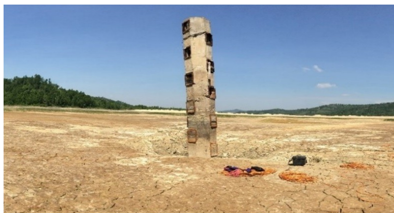
Дренажный колодец на площади хвостохранилища в Забайкалье
