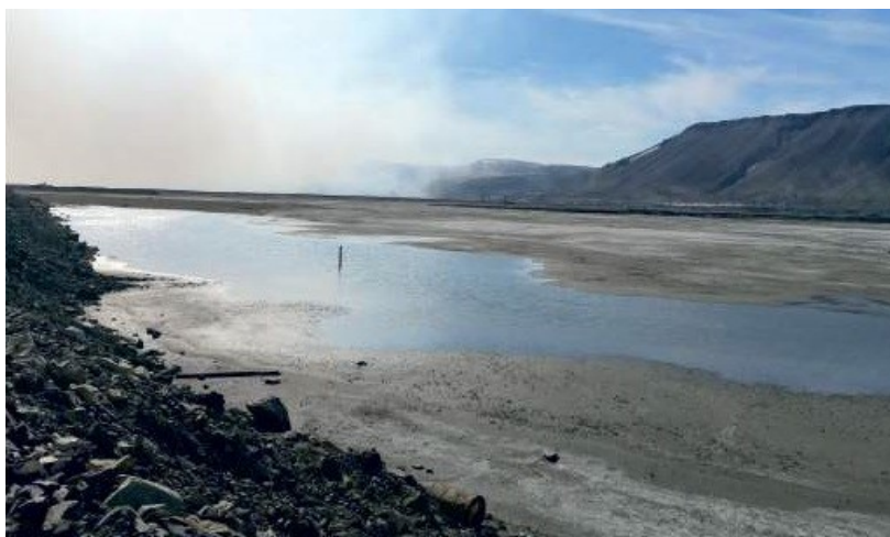
Одно из хвостохранилищ в Красноярском крае
