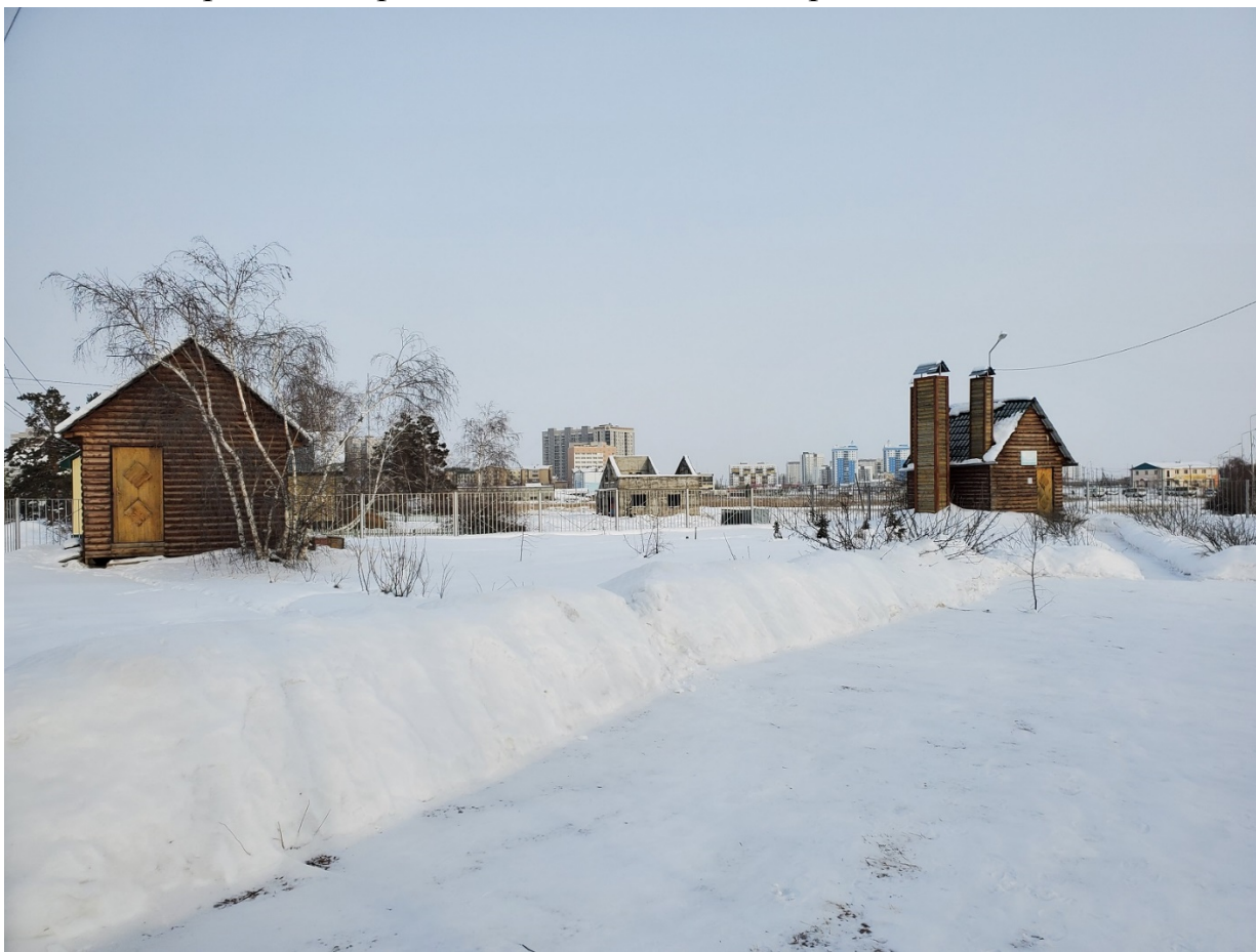
Первая очередь криохранилища в городе Якутске
